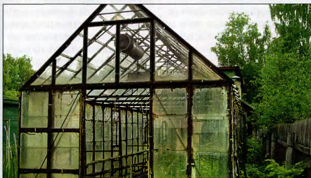
Конструкция зимней теплицы должна выдерживать снеговую нагрузку и элементы системы вентиляции, обогрева и отвода осадков
